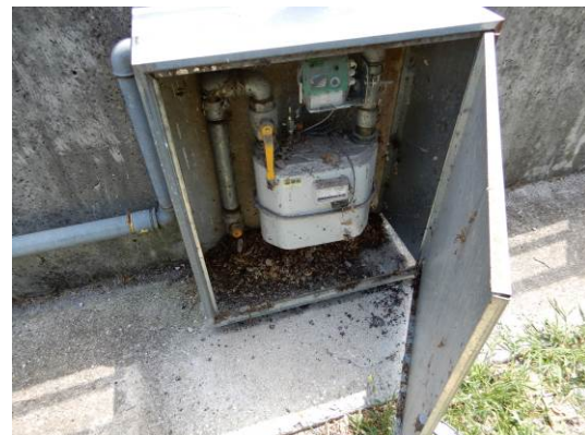
Foto 16: Vista degli armadietti metallici contenenti i contatori e valvole generali di intercettazione del gas per l'alimentazione della caldaia e del gas a d'uso dei “becchi bunsen”.
