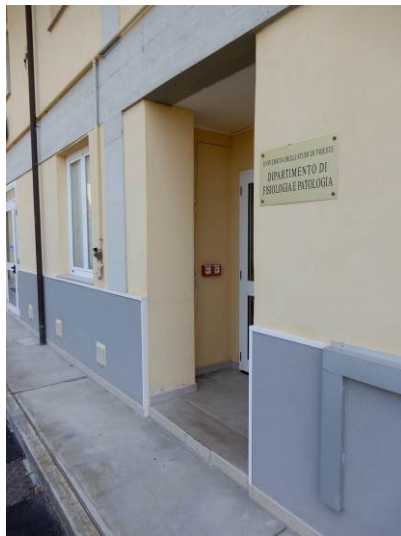
Foto 19: Vista dei pulsanti di sgancio generali dell'edificio, per la disattivazione dell'erogazione delle rete elettrica normale e del gruppo elettrogeno.
