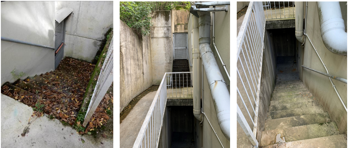
Foto 13: Vista della scala di emergenza esterna dal pianerottolo esterno alla stanza 227 della porzione di edificio "Ra" e via di uscite al piano terra dalla stanza 002a
