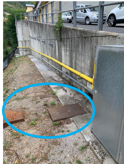
Foto 21: Vista dei pozzetti sottosuolo per l'alimentazione idrica dell'edificio R-RA.
