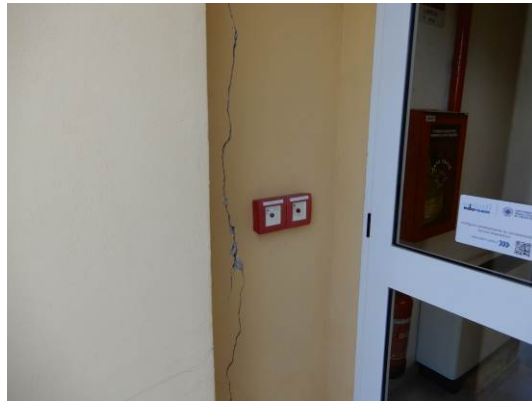
Foto 19: Vista dei pulsanti di sgancio generali dell'edificio, per la disattivazione dell'erogazione delle rete elettrica normale e del gruppo elettrogeno.
