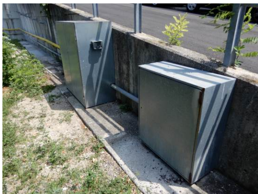
Foto 16: Vista degli armadietti metallici contenenti i contatori e valvole generali di intercettazione del gas per l'alimentazione della caldaia e del gas a d'uso dei “becchi bunsen”.
